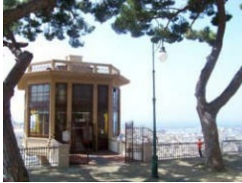
Genova, l'ascensore di Castelletto
